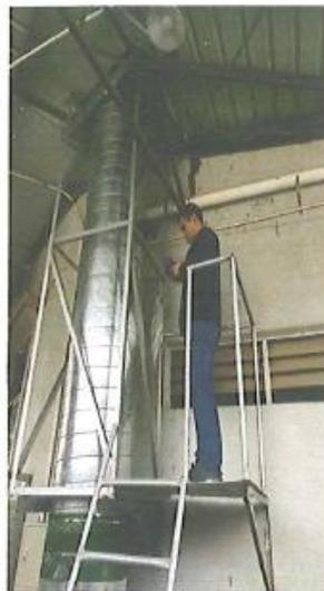
图2 注塑废气排气筒采样口
