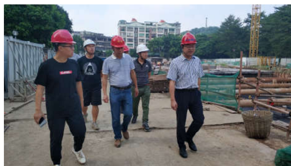
江门市住建局检查江门市东湖公园北园区配套服务设施及地下人防工程（人防工程部分）
