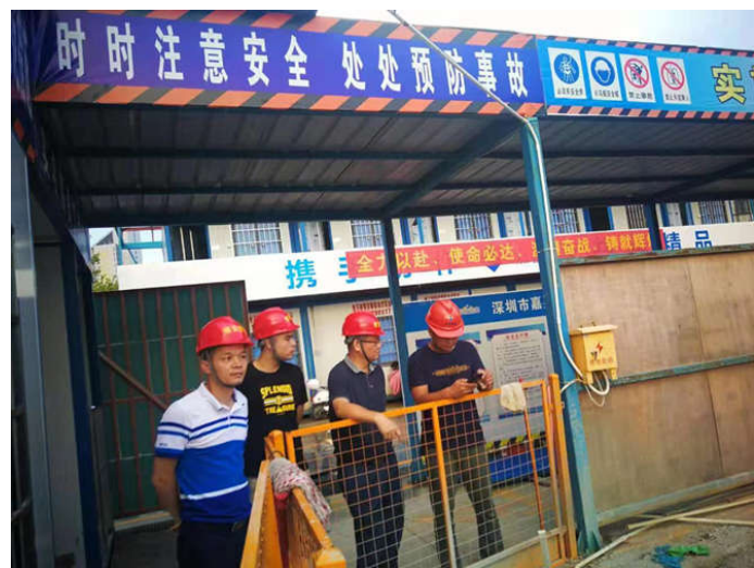
恩平市住建局检查恩平锦绣香江花园二期项目总承包工程
