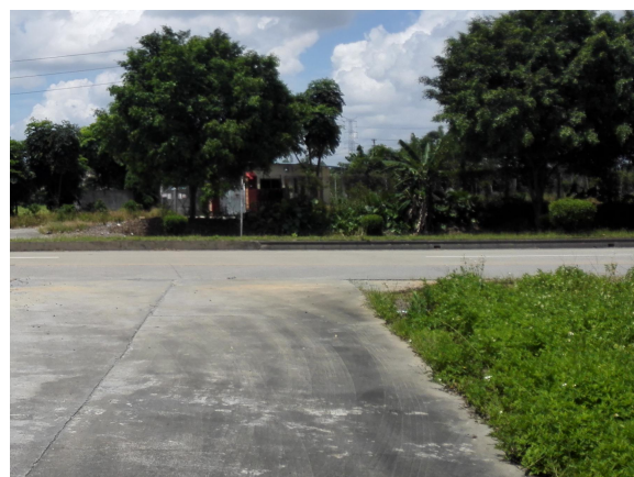
项目南面（北昌西路）
