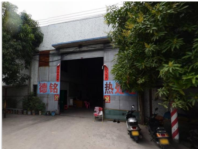
项目东面德铭热处理厂
