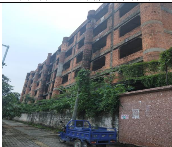
项目西面：空置厂房
