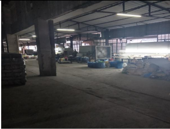
项目车间现状
