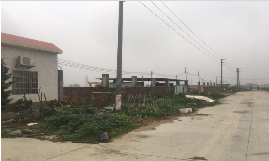
东面在建工地
