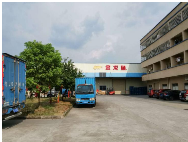
项目东面金龙鱼仓库
