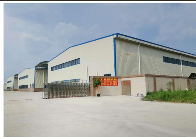
项目北面新建厂房
