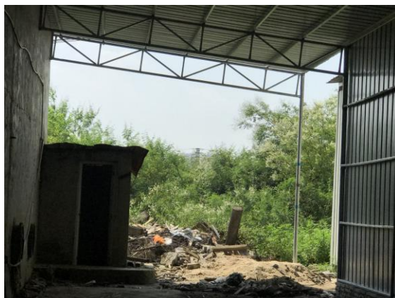
项目西面 空地
