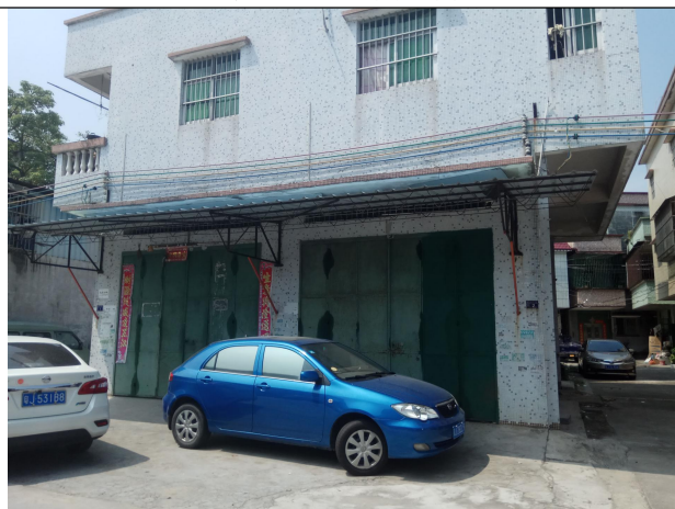
西面：隔道路为安吉村
