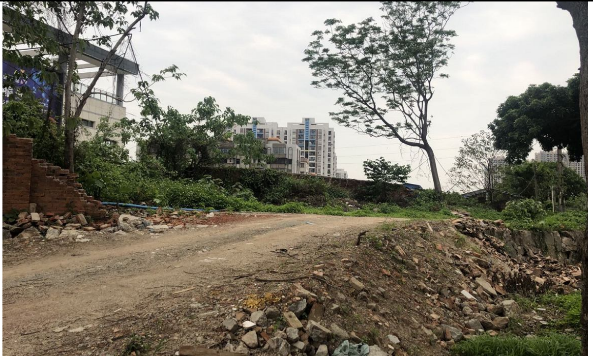
图 2-4 现状道路红线内部分建筑已拆迁
