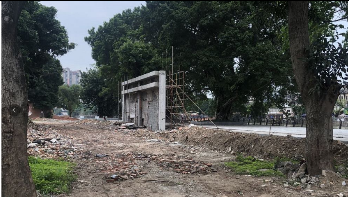
图 2-10 K0+310~K0+480 段、K0+740~K0+892.254 段已拆迁部分房屋
