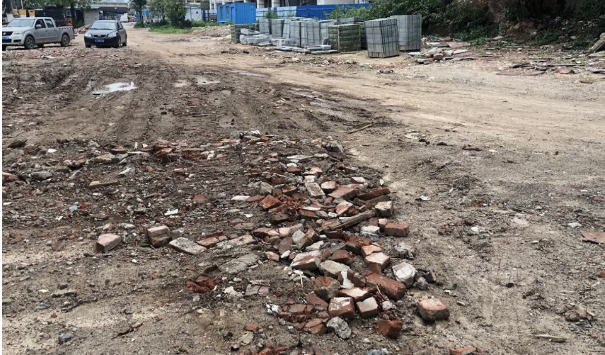
图 2-9 K0+115～K0+310 段、K0+480～K0+740 段已清除建筑废料和生活垃圾
