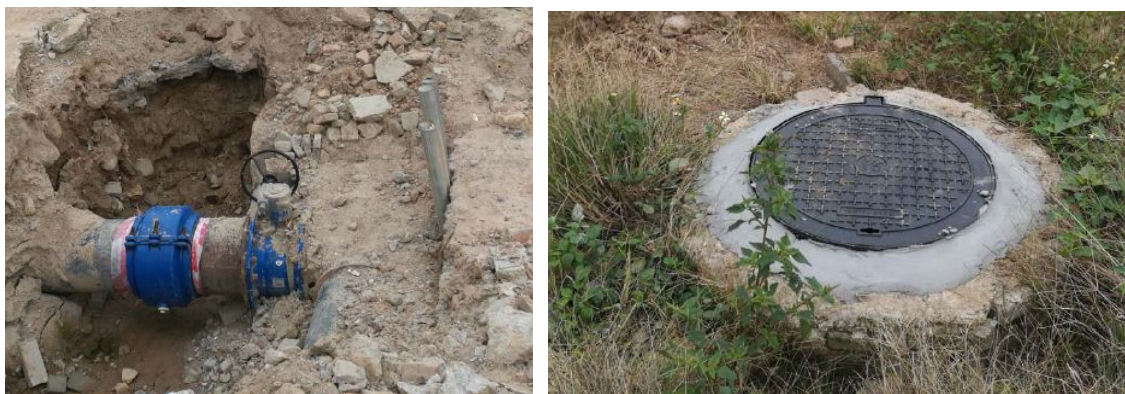
图 2-7 道路现状供水管、排水检查井
