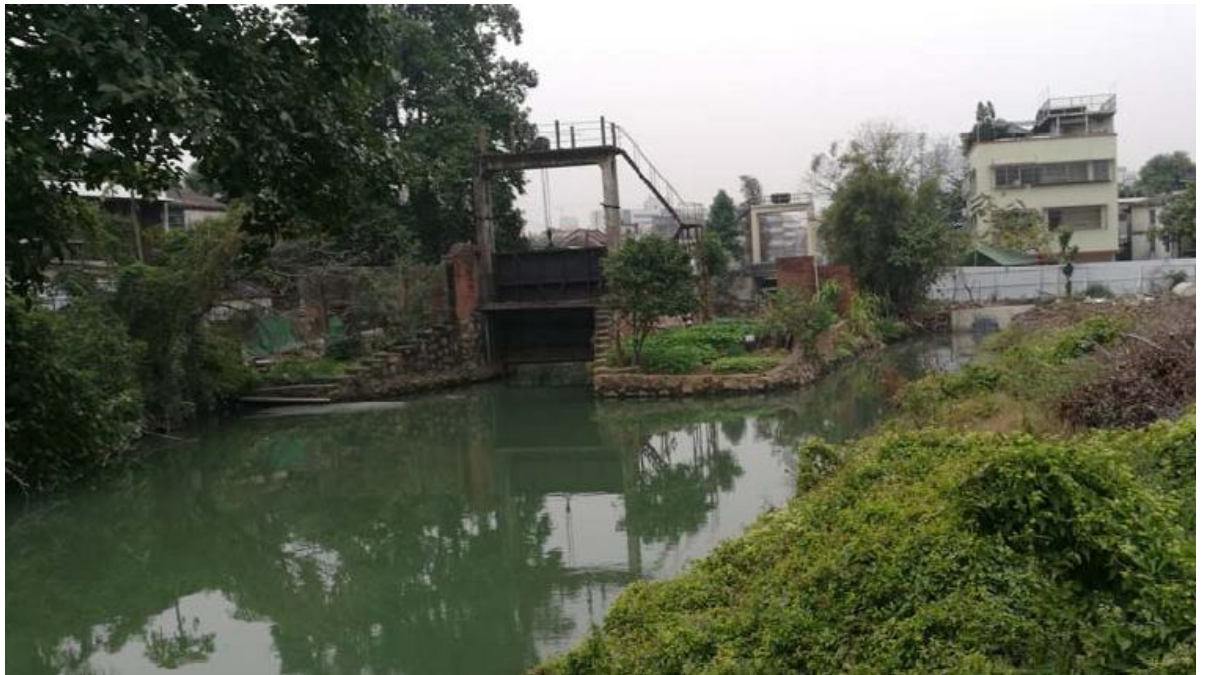
图 2-5 道路西侧现状为废弃水闸
