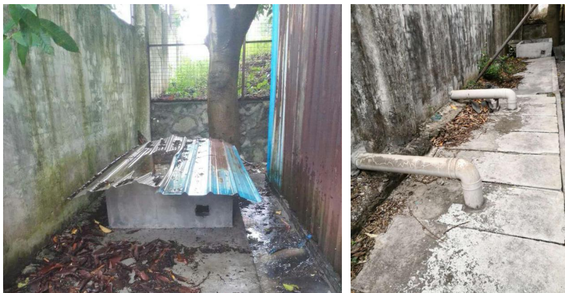
图 6.2-3 生活废水处理设施
