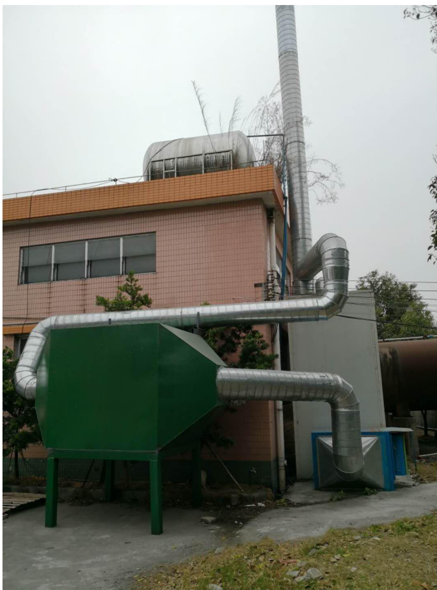
图 6.1-1 炼胶车间废气处理装置图
