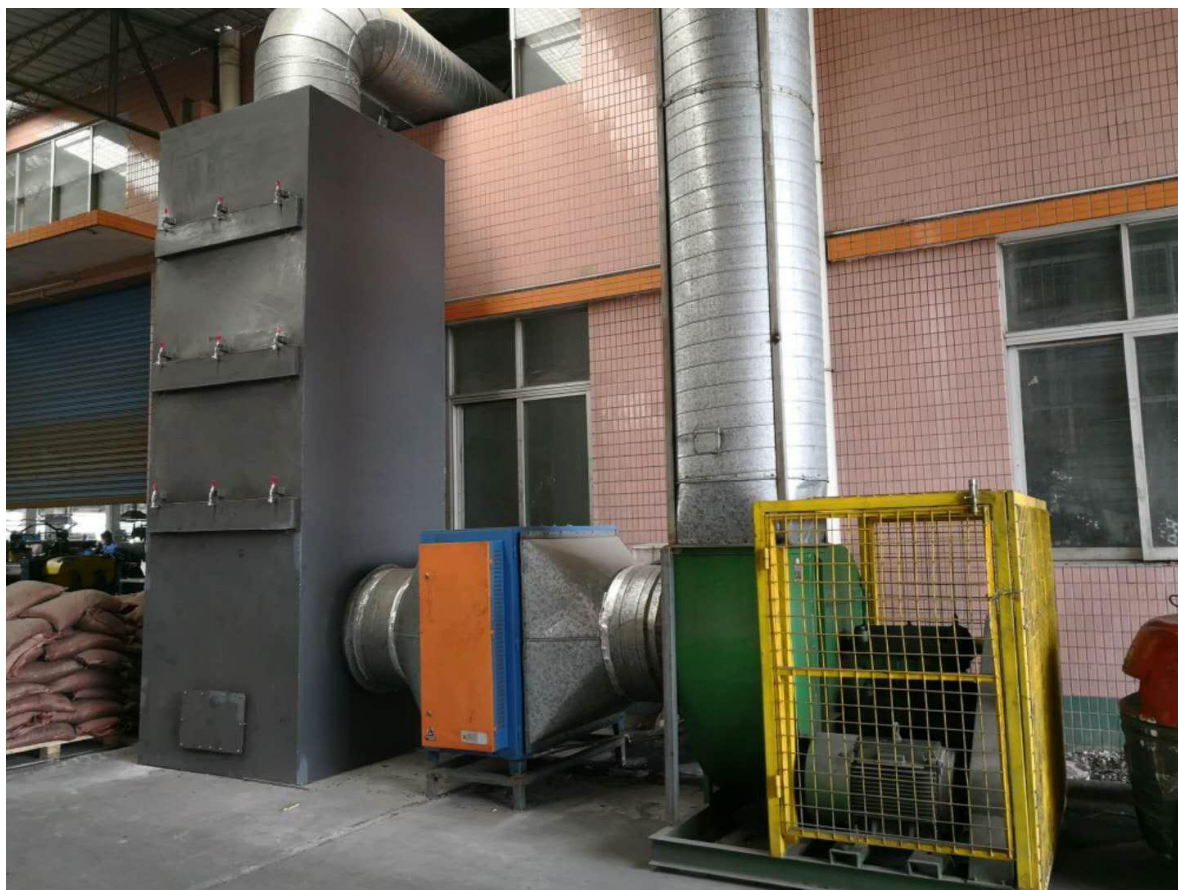
图 6.1-2 涂胶车间废气处理装置图
