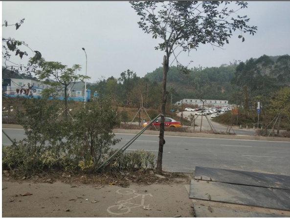
项目北面——群华路
