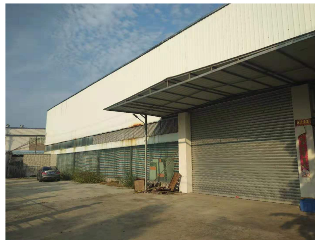
项目北面 厂房
