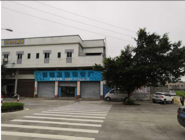
项目北面（空置店面）
