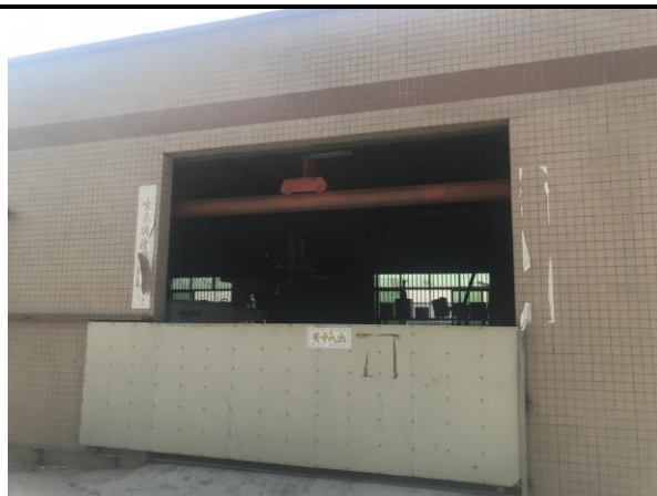
项目西面：仓库
