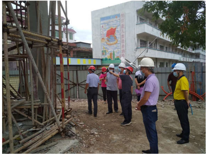
开平市住建局检查“幕村小学北教学楼”项目
