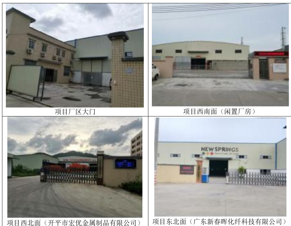
图 2.1-2 项目现状及周边现状图
