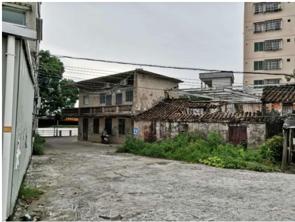
项目西面废弃楼房
