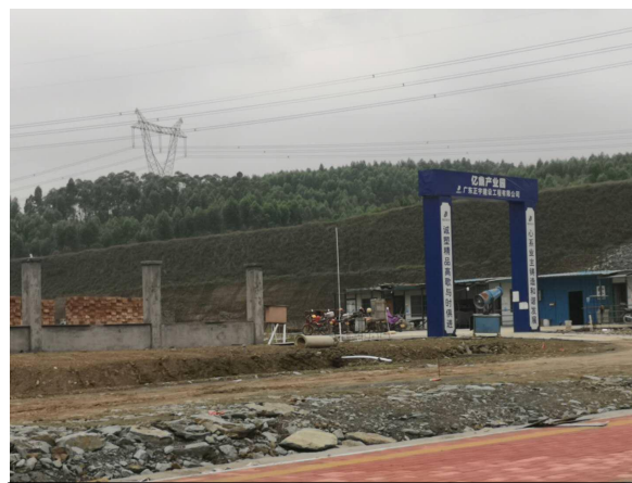
西面：在建工地
