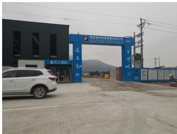
南面：在建工地
