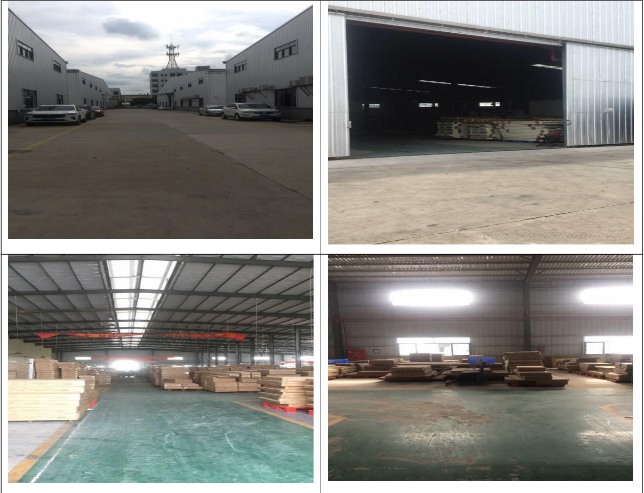
项目现场硬底化照片
