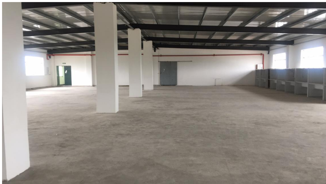
图7-3 厂区内外硬底化照片
