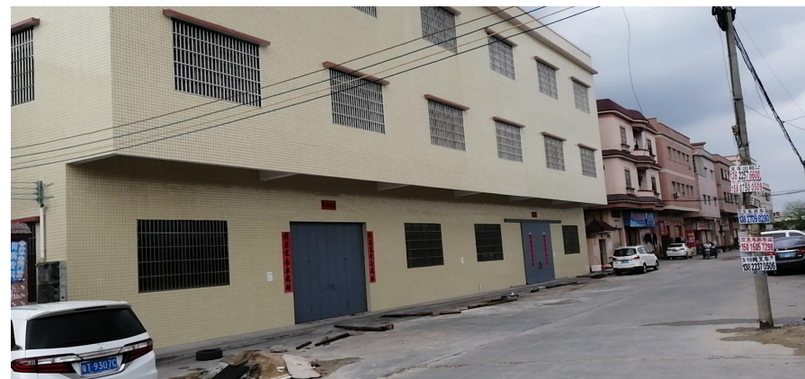
东北面空厂房
