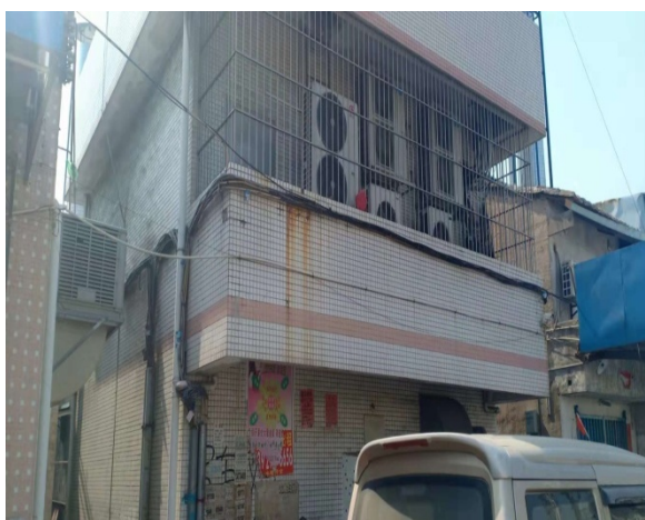
1 号和 2 号厂房中间：电信塔房
