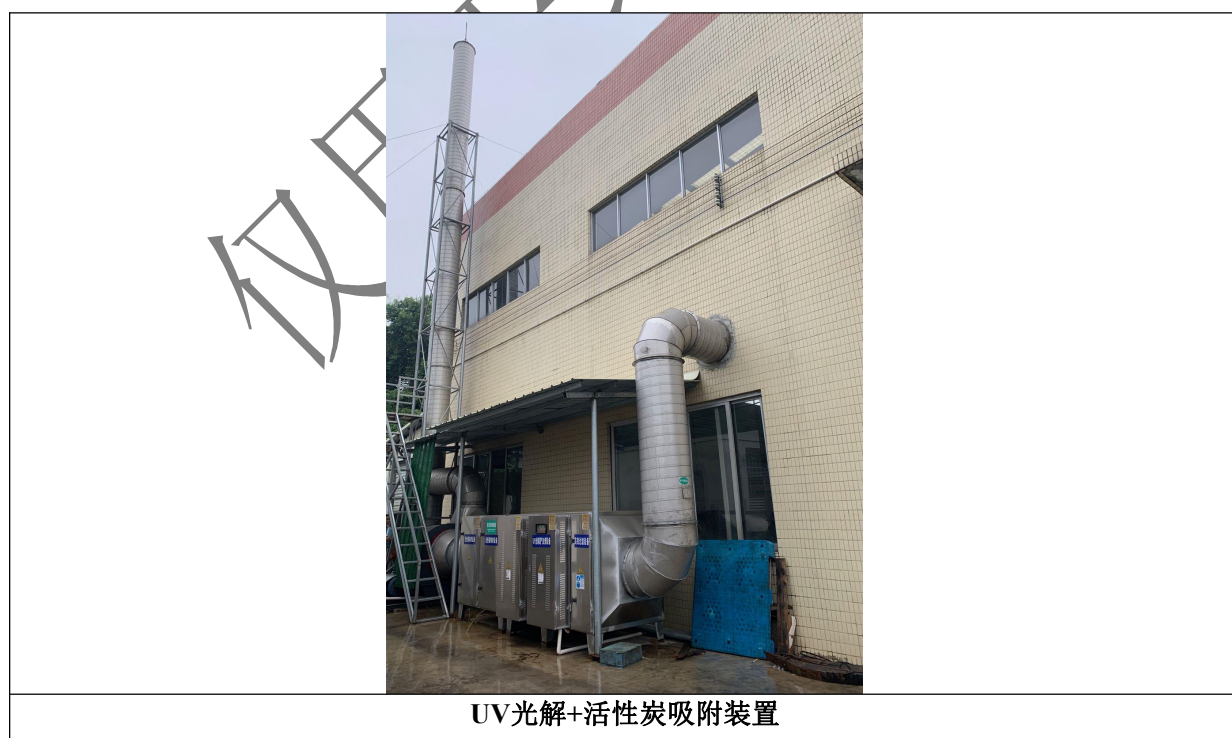
图6.2-6 注塑车间废气治理设施现场图
