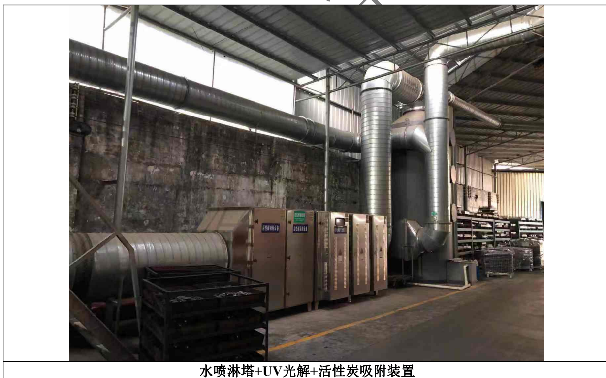
图6.2-3 （排气筒P1）废气治理设施现场图
