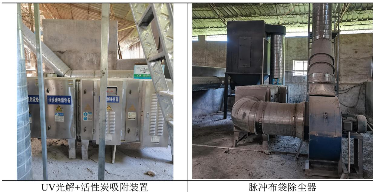
图6.2-6 混炼车间废气治理设施现场图
