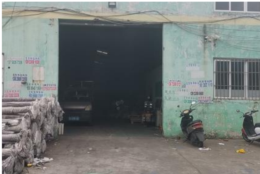
图 7-3 厂区硬底化照片
