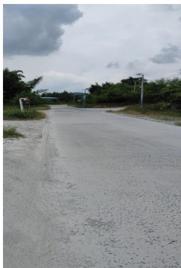
图 1-1 道路现状照片
