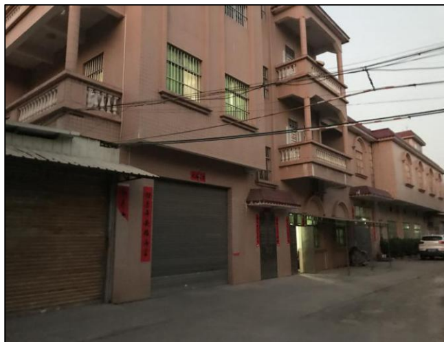
项目西面本项目业主房屋
