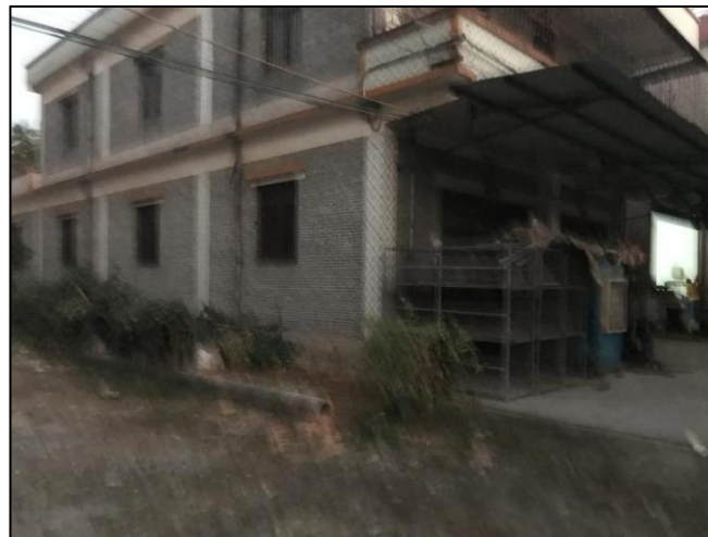
项目南面工业仓库
