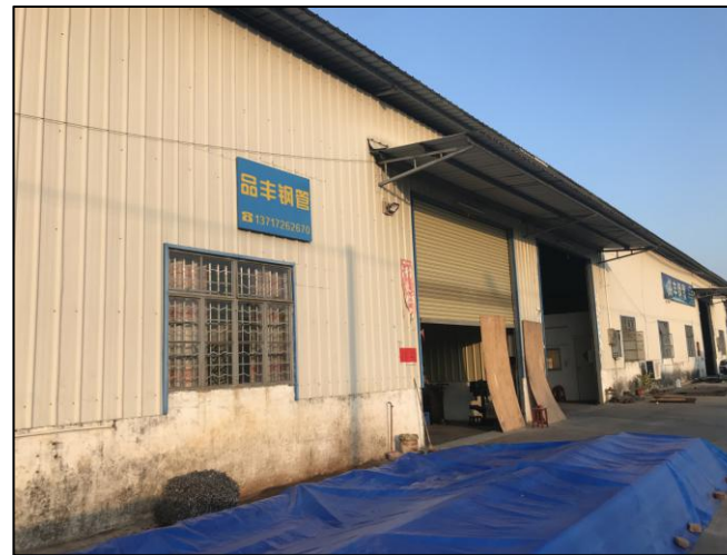
项目南面钢管厂
