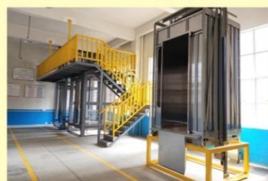
新落成电梯二期实训室
