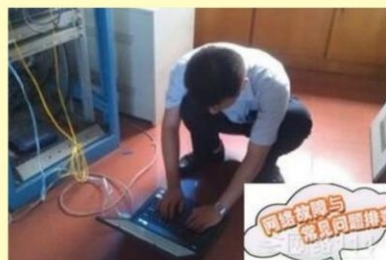
网络安装与维修室
