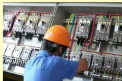
照明安装实习
