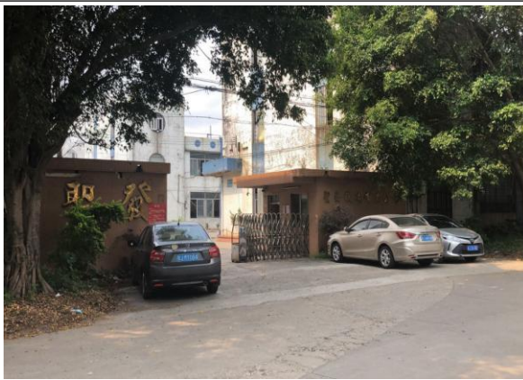
项目东面——圣发制造有限公司厂房
