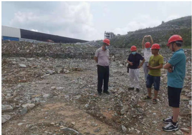
恩平市住房和城乡建设局检查“广东全圣陶瓷有限公司陶瓷机械生产项目”
