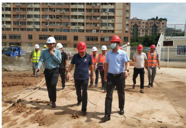
江门市住房城乡建设局检查“五邑大学综合体育馆工程”
