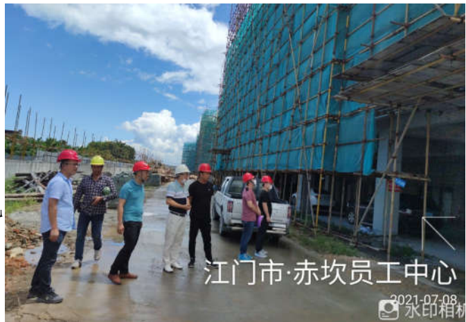
开平市住房城乡建设局检查“赤坎古镇员工中心”
