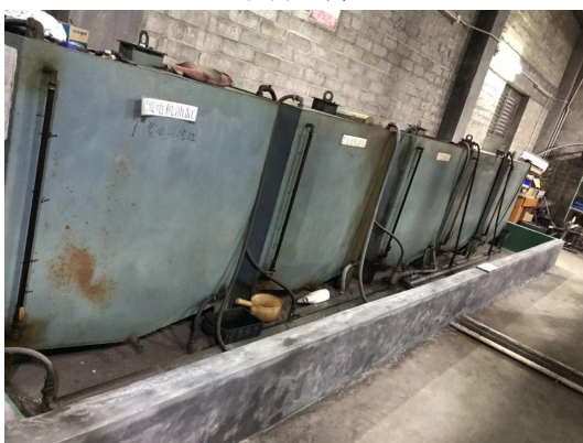
柴油储罐及围堰
