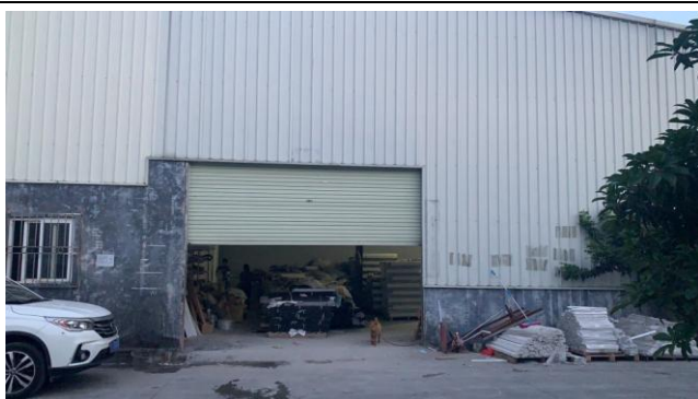
项目西北面（无名厂房）
