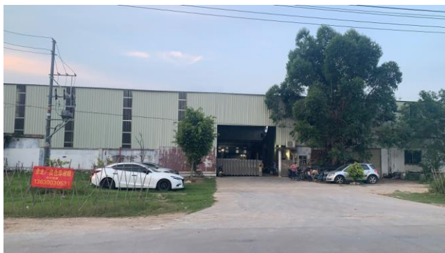
项目东北面（无名厂房）
