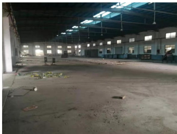
本项目车间现状
