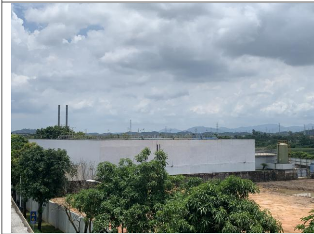
本项目东面原有项目污水处理站
