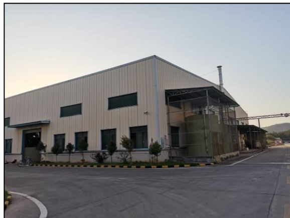
项目东南侧 A2 号地块现有厂房
