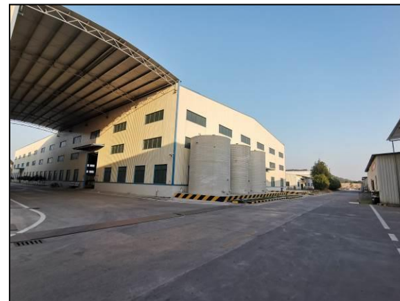
项目东南侧 A3 号地块已建成车间六
