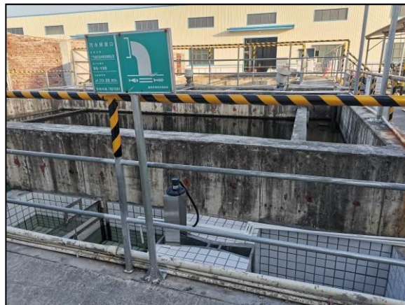
项目项目西北侧污水站
