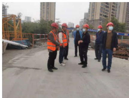
恩平市住房城乡建设局检查“恩平锦绣香江花园二期J栋、二期K栋、地下停车场（一期）”
