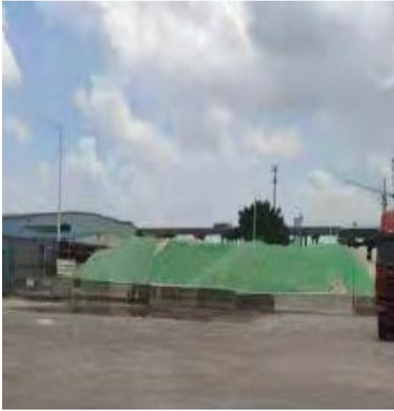
图3.3.2-1 砂石堆场现场图（防风抑尘网）
