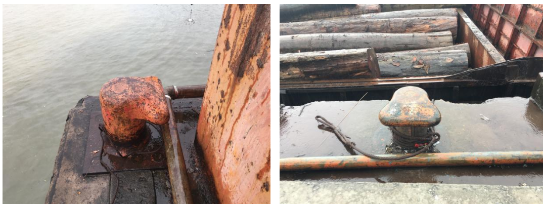
图 3.2.6-3 系缆设施现状图
