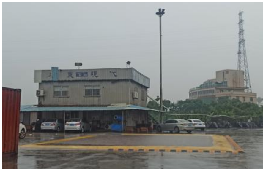
图3.3.2-4 汽车进出场清洗池
