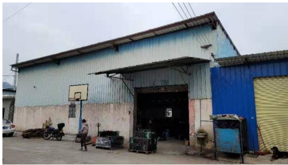
项目东面——废弃厂房
