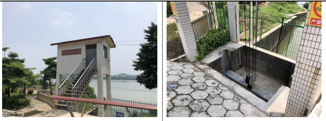
图 5-1 周郡水闸现场照片
