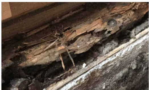
木柱侧弯变形，或柱顶劈裂、柱身断裂、柱脚腐朽等受损面积大于原截面20%以上。——存在严重安全隐患。
