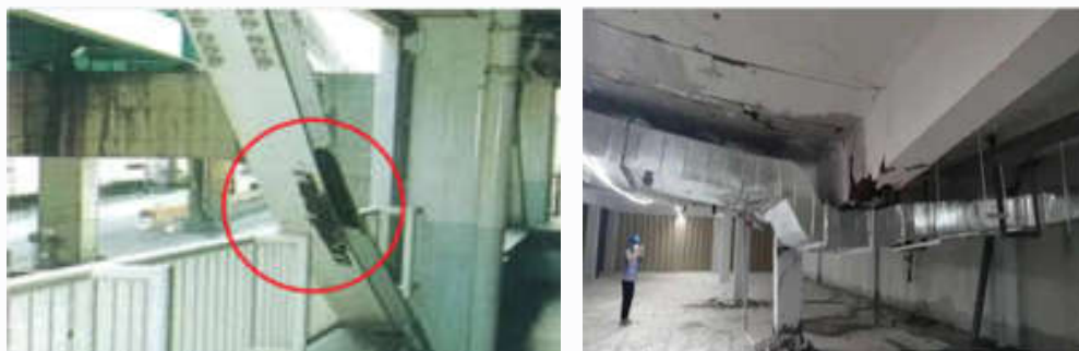
房屋建筑承重构件在建筑荷载作用下发生变形
