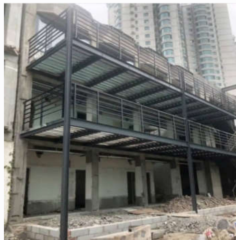
在原楼（屋）面新增的架空层与原结构缺乏可靠连接；——存在严重安全隐患。
