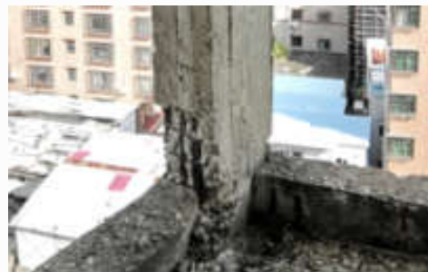
房屋建筑砌体材料出现风化剥落、混凝土保护层脱落、木材腐烂虫蛀等。
