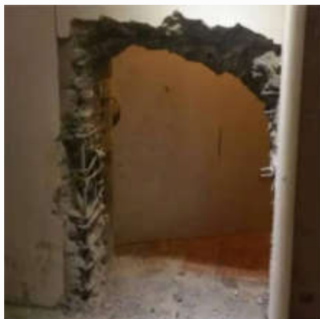
房屋产权人（使用人、管理人）非法拆除房屋承重墙、柱，改变房屋结构。
