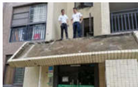
房屋建筑的阳台、女儿墙等与主体连接处存在开裂、损伤，导致阳台、女儿墙等发生坍塌。
