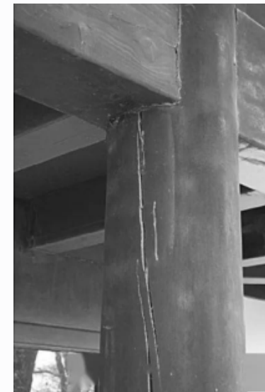
受压或受弯木构件干缩裂缝深度超过构件截面尺寸的1/2, 且裂缝长度超过构件长度的2/3。——存在一定安全隐患。
