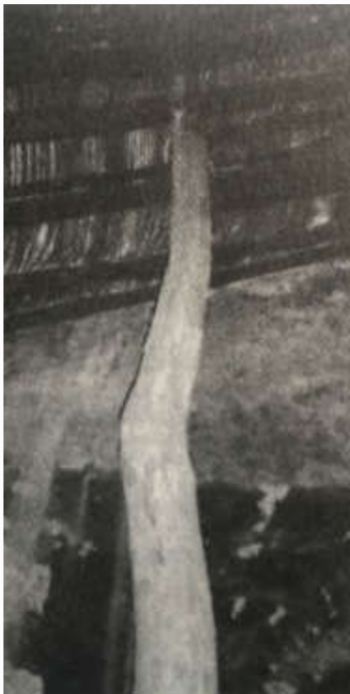
木柱侧弯变形，或柱顶劈裂、柱身断裂、柱脚腐朽等受损面积大于原截面20%以上。——存在严重安全隐患。
