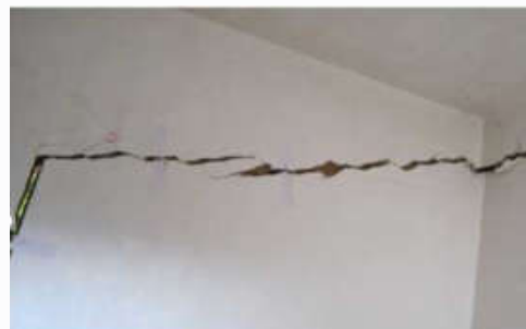
房屋建筑承重墙、柱等在建筑荷载作用下产生张拉裂缝。
