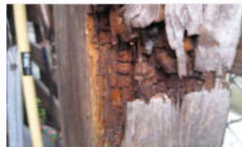
房屋建筑砌体材料出现风化剥落、混凝土保护层脱落、木材腐烂虫蛀等。
