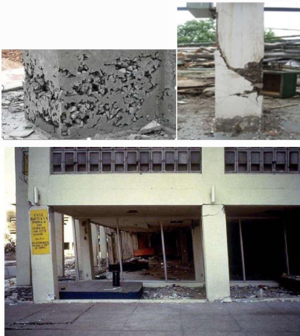
主要承重柱产生明显倾斜，混凝土质量差，出现蜂窝、露筋、裂缝、孔洞、烂根、疏松、外形缺陷、外表缺陷——存在严重安全隐患。
