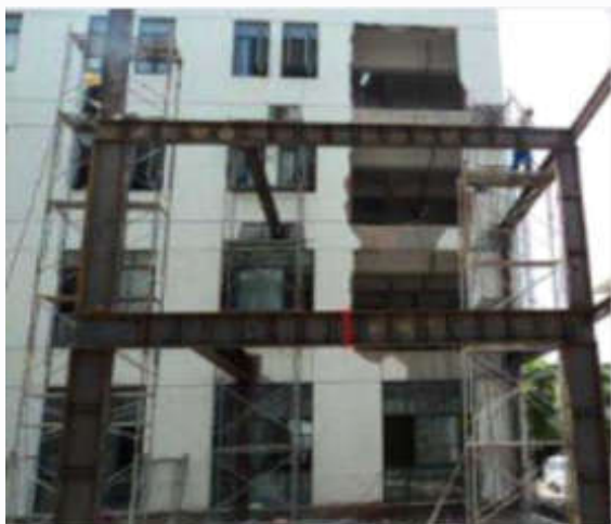
在原楼（屋）面新增的架空层与原结构缺乏可靠连接；——存在严重安全隐患。
