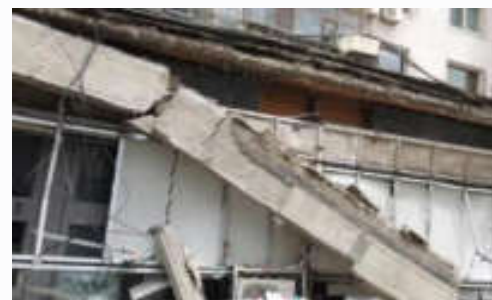
房屋建筑的阳台、女儿墙等与主体连接处存在开裂、损伤，导致阳台、女儿墙等发生坍塌。
