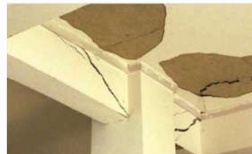
房屋建筑承重墙、柱等在建筑荷载作用下产生张拉裂缝。
