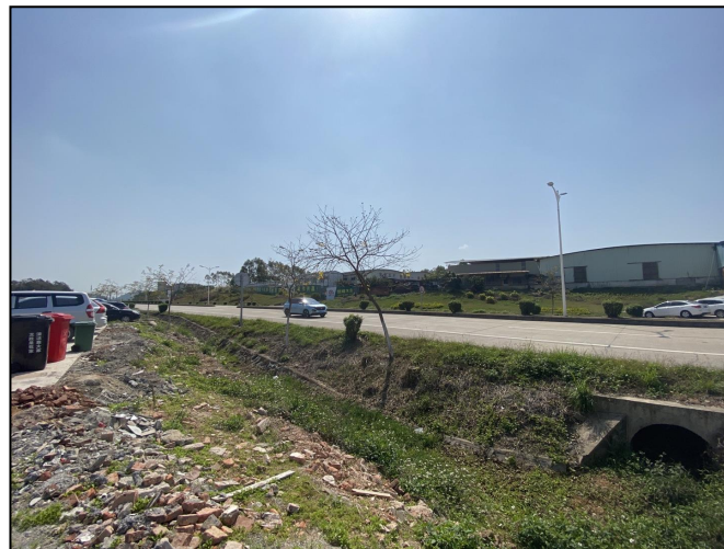
项目南面 S274 省道
