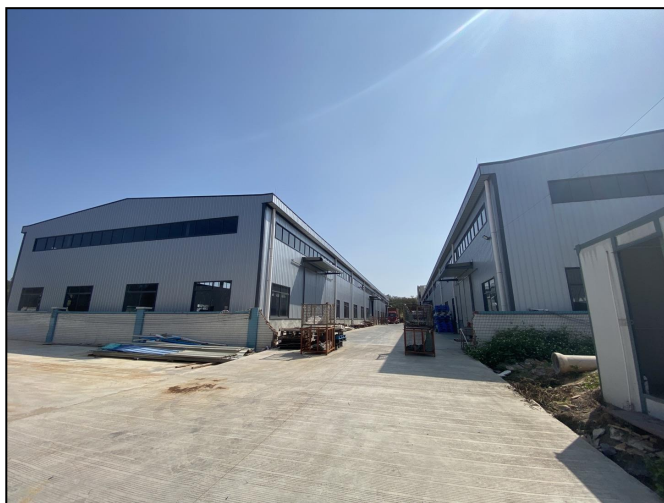
项目东面工业厂房
