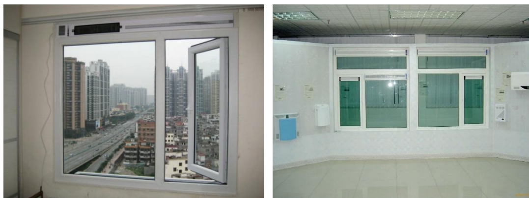
图 6.2-4 通风隔声窗应用实例
