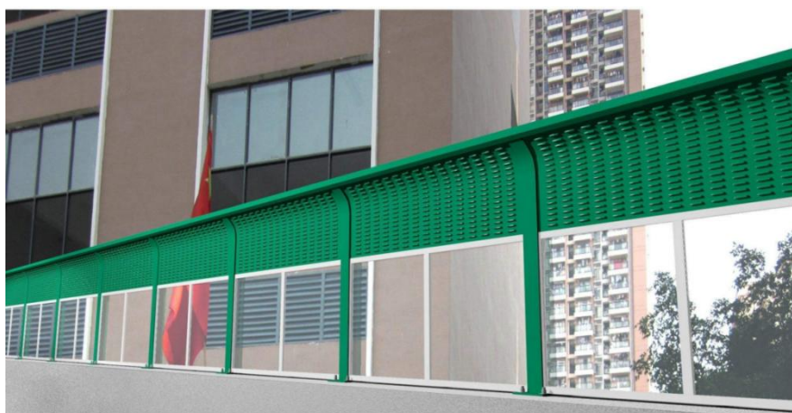
图 6.2-1 直立式声屏障工程实例图
