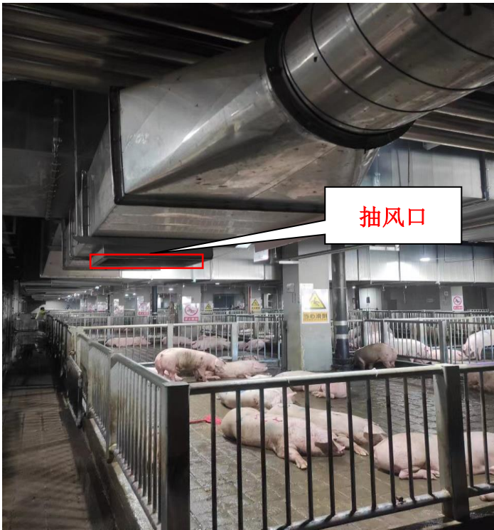
图 4.7-2 待宰栏抽风装置示意图
