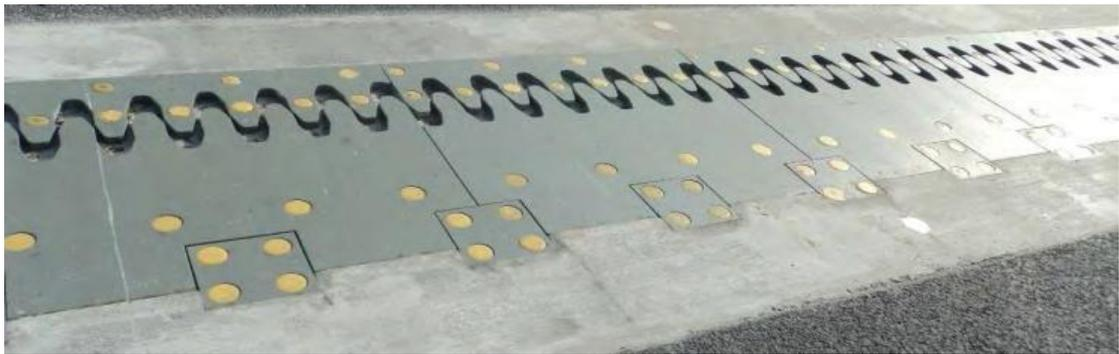
图 6.2-1 降噪型伸缩装置工程实例图
