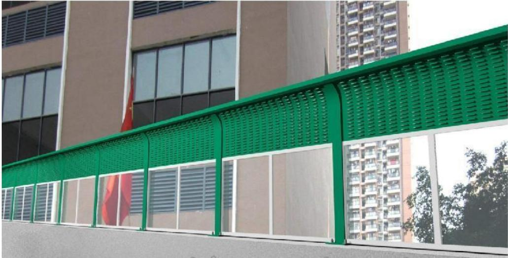
图 6.2-2 直立式声屏障工程实例图
