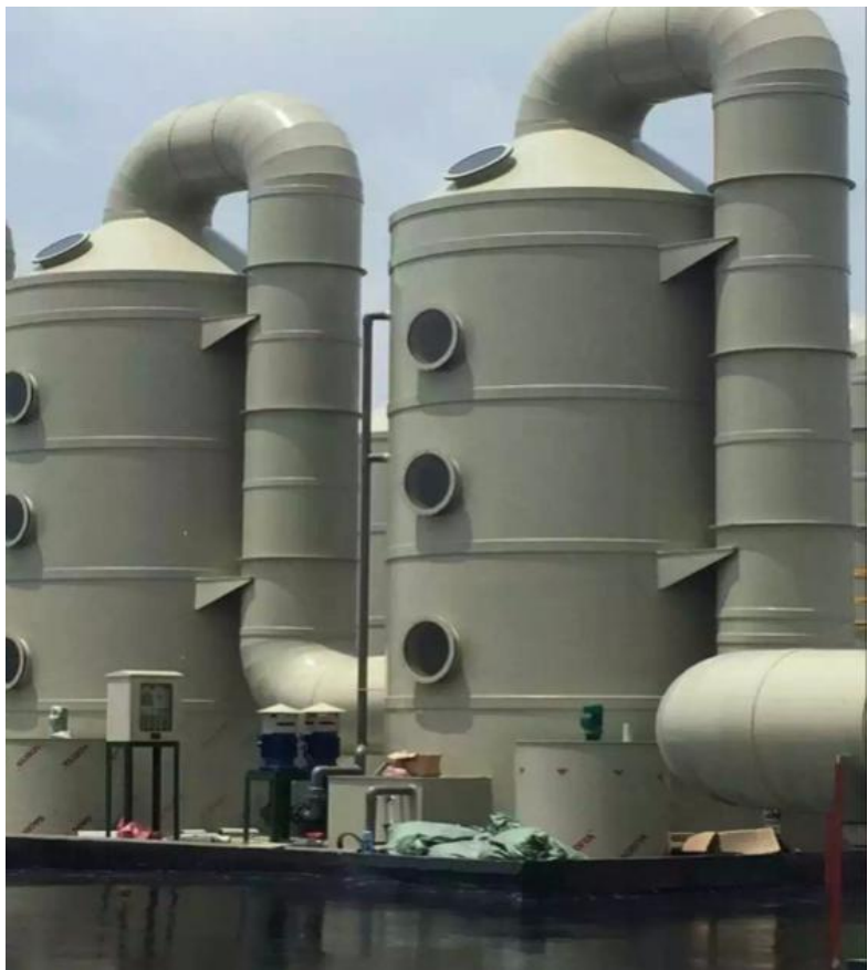
图 6.3-2 生物除臭塔装置图
