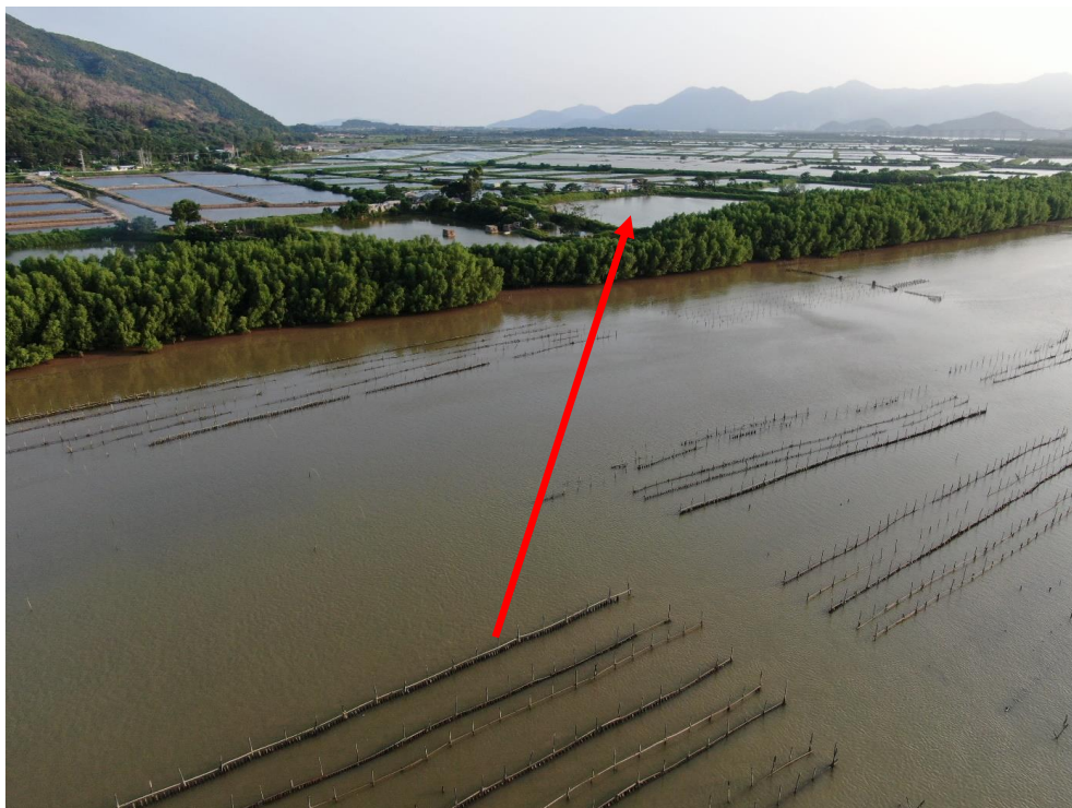
图 9.2-2 桥位现场实景图（前进方向为大桩号）
