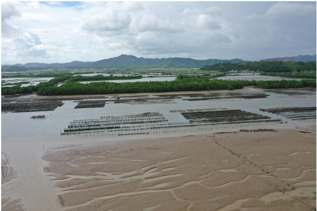
图 2.4-3b 深井河大桥选线处现状航片（2021.7.7）
