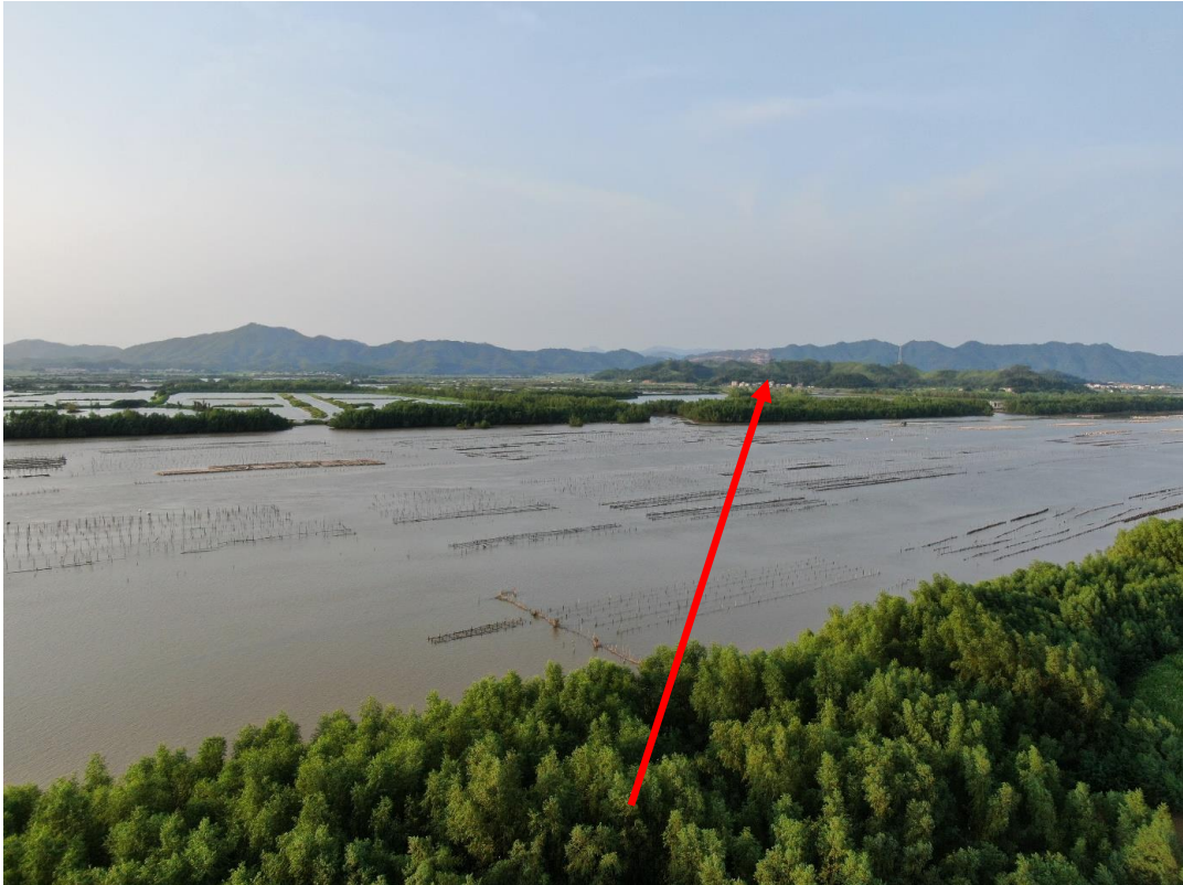
图 9.2-1 桥位现场实景图（前进方向为小桩号）
