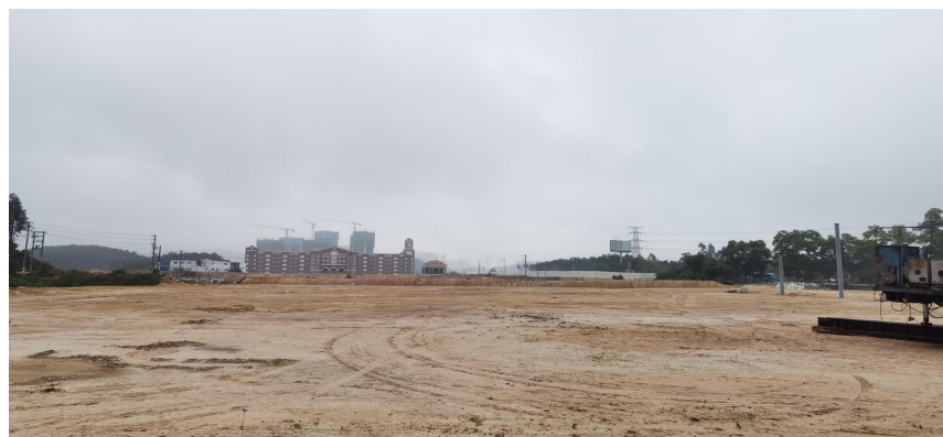
北面：开平市光正实验学校-建设中
