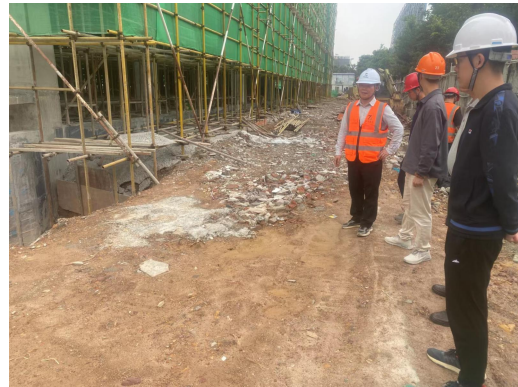
新会区住房和城乡建设局检查“新会工业设计总部大厦(孵化器)”
